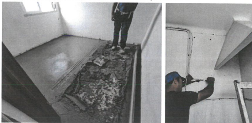
Substituição de pavimentos degradados ou alterações em redes técnicas
